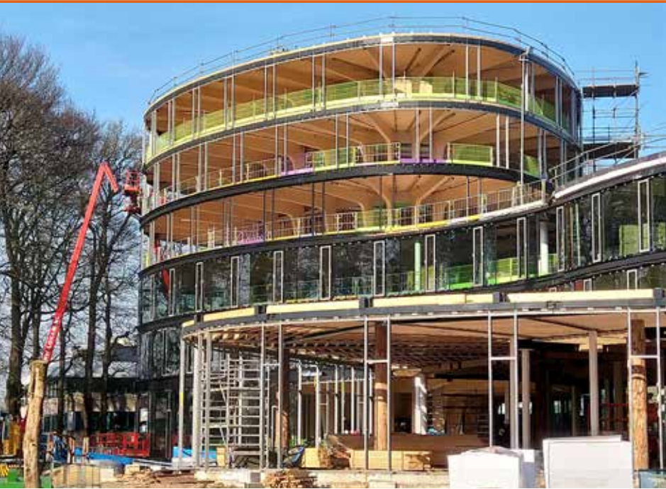
Figuur 1 Het hoofdkantoor van de Triodos bank is geheel in hout uitgevoerd. Foto: Jan den Ouden.
